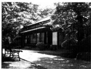
写真一九 「松陰 commons」の外観写真
